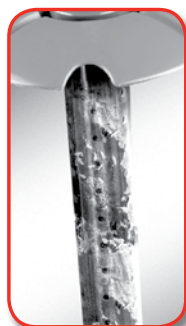
La presencia de termitas en la estaca
